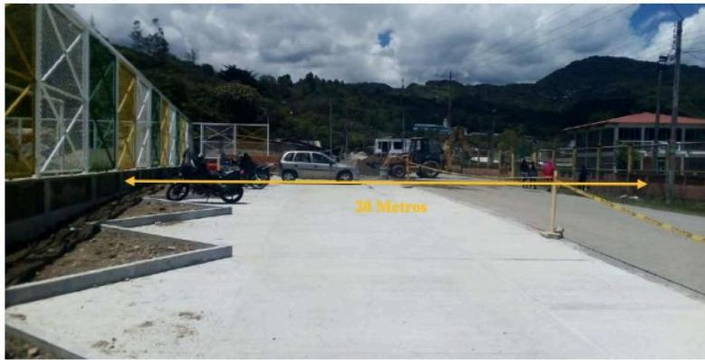
Fotografía No.2 - Inicialmente se tenía una separación entre cierros de 13,2 metros actualmente tiene una distancia promedio de 20 metros.
