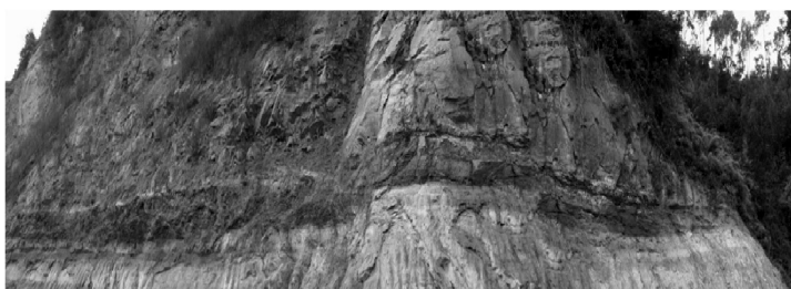
Figura N° 8 Talud deslizado de caleta Cocholgüe: estructura estratificada y fallada de las rocas sedimentarias
