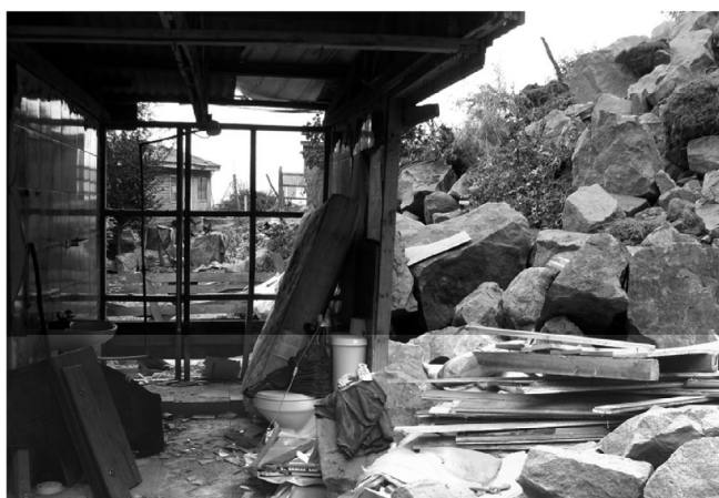
Figura N° 5 Desprendimiento de roca caleta Los Bagres
