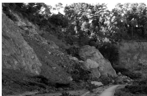
Figura N° 7 Deslizamiento de rocas cósmico, camino de acceso a Cocholgüe
