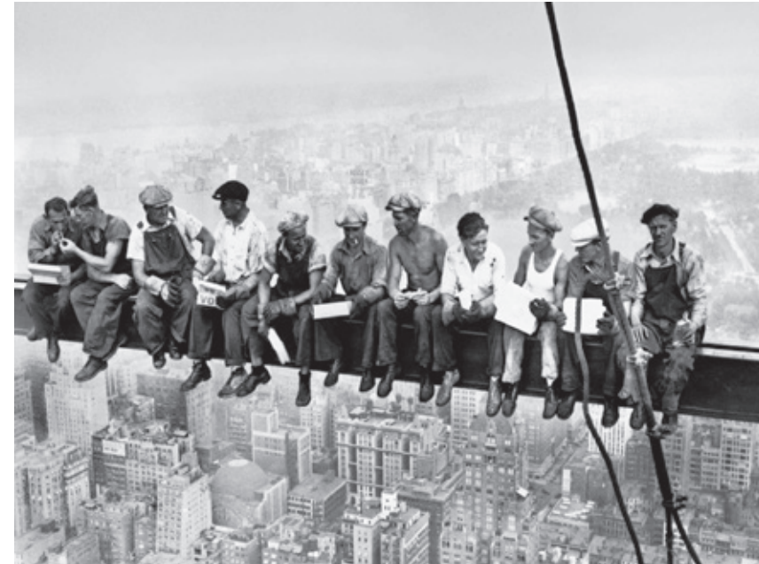
29 de septiembre de 1932: Trabajadores de la construcción almuerzan sobre una viga de acero a 250 metros del suelo durante la construcción del edificio RCA en el Rockefeller Center. Sep 29, 1932: Construction workers eat their lunches atop a steel beam 800 feet above ground at the building site of the RCA Building in Rockefeller Center. Fotografía /Photograph: Atribuida a /Attributed to Charles C. Ebbets. Fuente /source: New York Herald Tribune.
