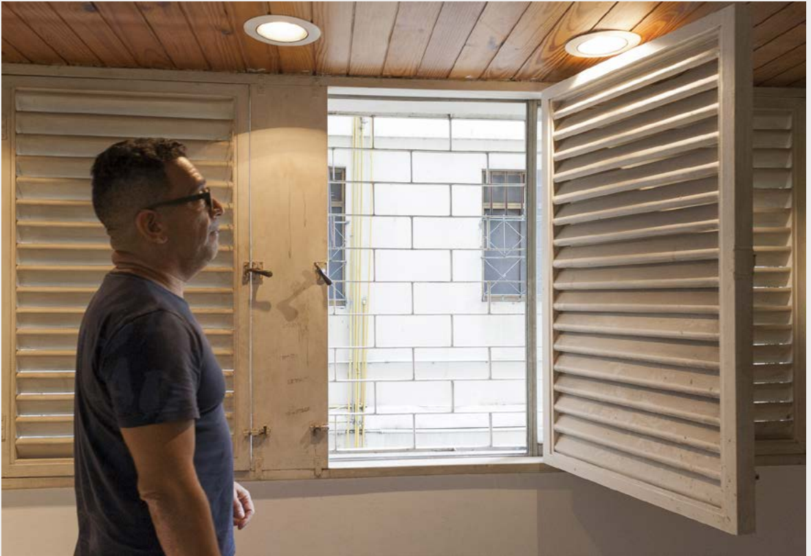
Figura 3: Frente al doble cerramiento para controlar la luz y la ventilación. Fotografía del autor (trabajo de campo en Caracas, noviembre, 2022).
